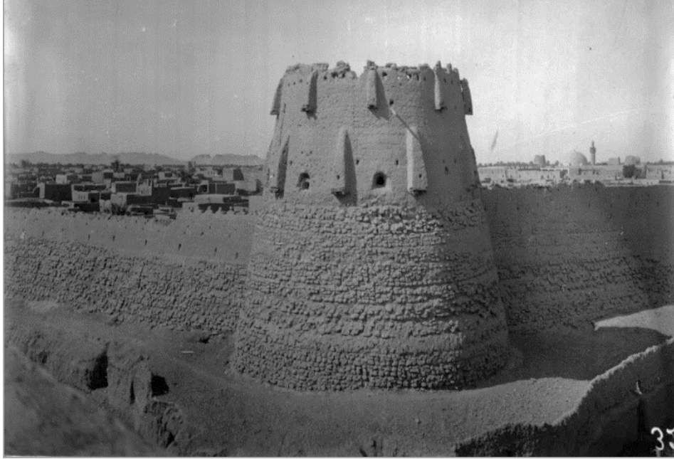
اللوحة ١ البرج الركني الجنوبي الشرقي لحي الكوت. (٤) (١٩٠٤ م: هيرمان بورخارت). (٥)
