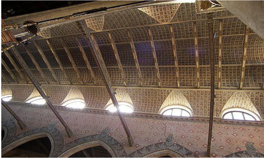
(شكل 4) نموذجاً لأسلوب تغطية أسقف الكنائس الأرثوذكسية
